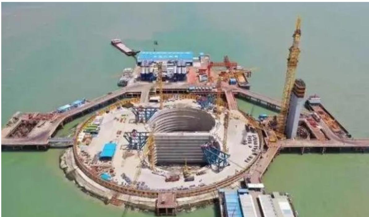
深中通道管理中心相关负责人透露,项目东锚碇基坑开挖施工的难度主要存在两方面。一是超大规模锚碇基坑位于全海洋环境,国内外可借鉴工程经验少、安全风险高、施工组织难度大,要求开挖、出土、内衬施工形成紧凑的流水线作业,才能确保基坑开挖施工安全、高效地完成。受新冠肺炎疫情影响,东锚碇基坑工程于今年3月中旬正式复工并启动开挖工作,期间经历珠江口的强降雨及强台风海高斯影响,基坑安全性未受影响,目前已经基本完成整个基坑的开挖工作,正在进行最后一层内衬的闭环施工。另一方面海中超深锚碇基坑开挖深度达42米(含水上、水下),相当于14层楼高。为解决超深海中基坑挖土的问题,采取了伸缩臂挖机+取土门架的综合开挖方案,既提升了基坑开挖的工效,同时满足了深基坑取土的高度要求。
